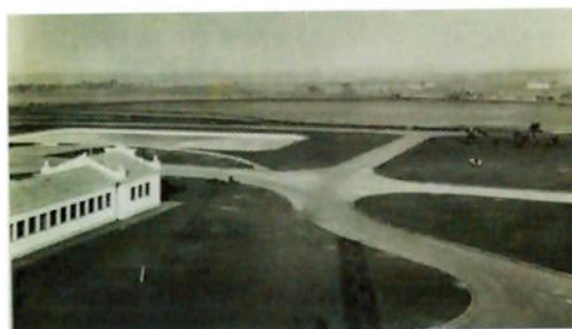
Foto 3. Construção do Prédio Central – Década de 40.
