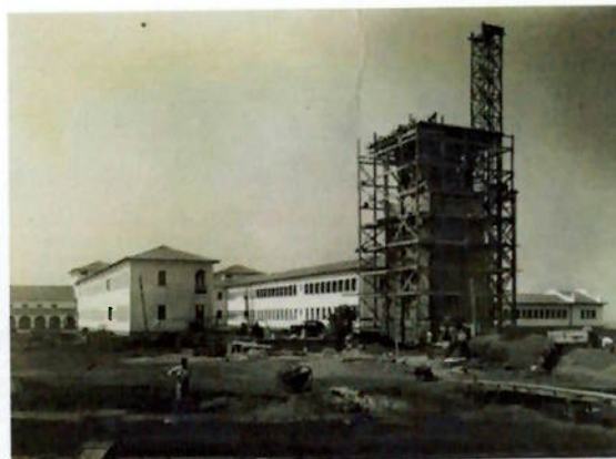
Foto 2. Construção do Prédio Central – Década de 40.
